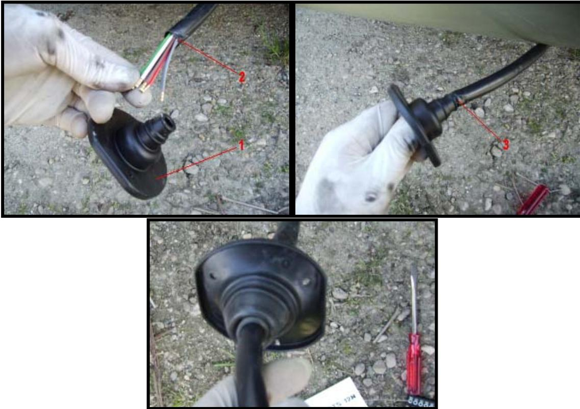
Figure 45 : Photos de l'enfilage de la protection en caoutchouc.
