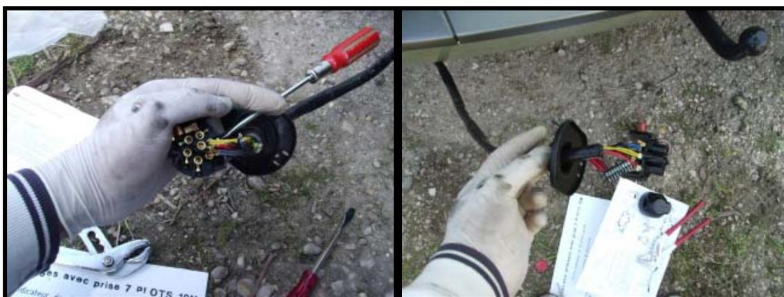
Figure 47 : Photos de la connexion des câbles à la prise de l'attelage.
