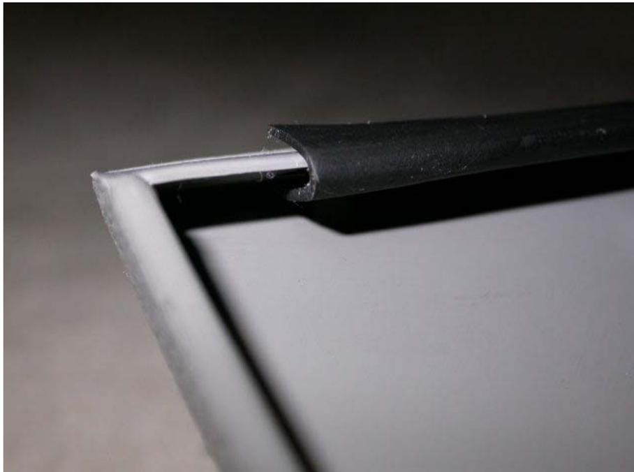
**Fig. 4:** Détail de fixation du joint.
